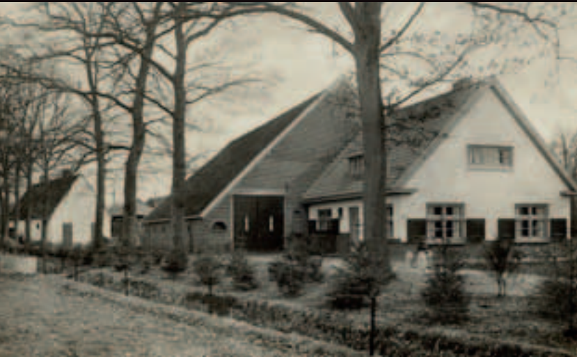
Boerderij Port Natal nog volledig in bedrijf. Nu afgebroken.
