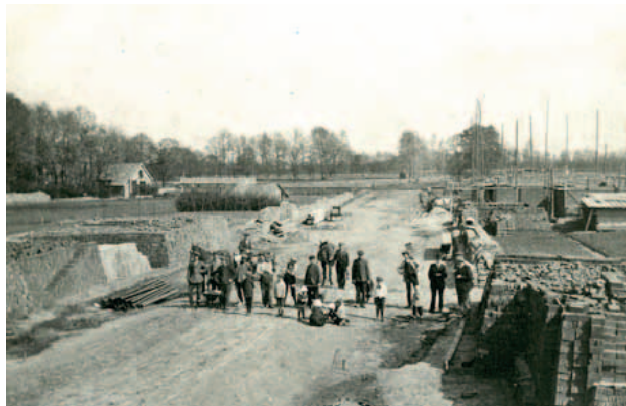
Aanleg Parkstraat 1918 in oostelijke richting
