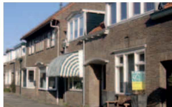
Eschstraat wederopbouw (gebouwd 4de kwartaal 1941)
